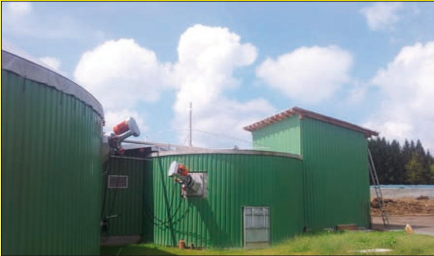
Bild 1: Hydrolysetanks ermöglichen die Vergärung faseriger Einsatzstoffe.
